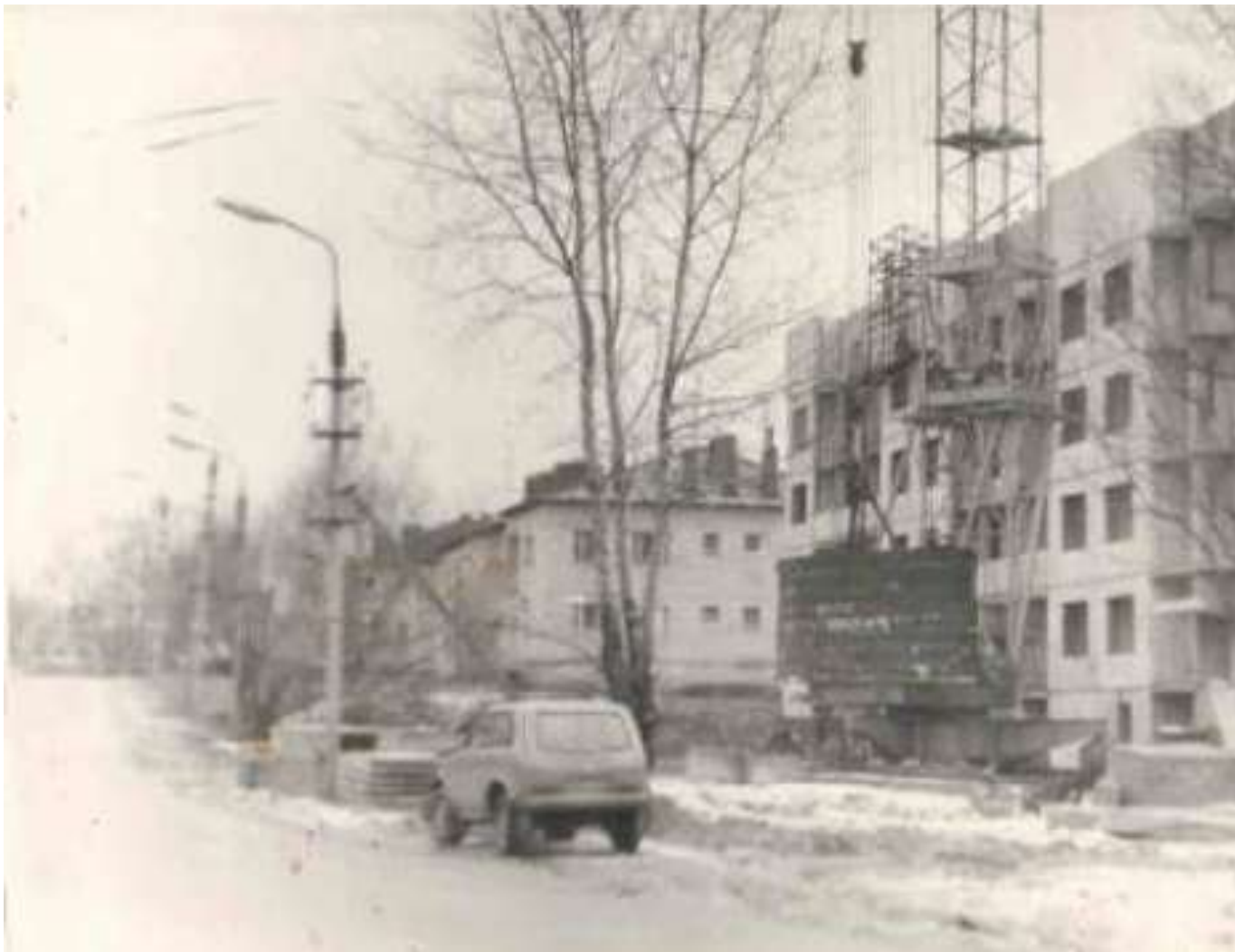
Строительство нового жилого дома на ул. Дзержинского, 1992 г. (материалы архивного отдела Администрации Куньинского района)
