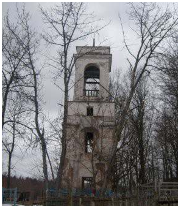
V. Колокольня погост Плотично
